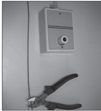
Knip het staaldraad \pm 25 cm voorbij het windwerk af.
